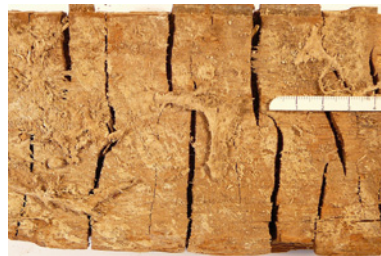
Bild 4.3 Braunfäule mit sehr groben Würfelbruch beim Echten Hausschwamm
