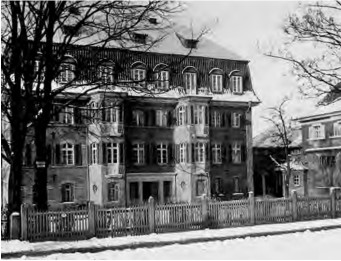
Die Teichstraße 17 in Stralsund, heute Friedrich-Engels-Straße, die Fotografie stammt aus dem Jahr 1927.
