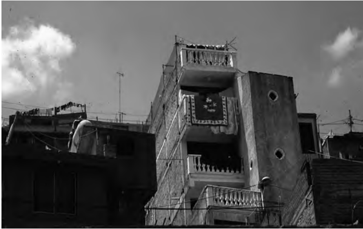
Abb.1: Balustrade in der Selbstbausiedlung San Nicolás Totolapan, Mexiko-Stadt.
